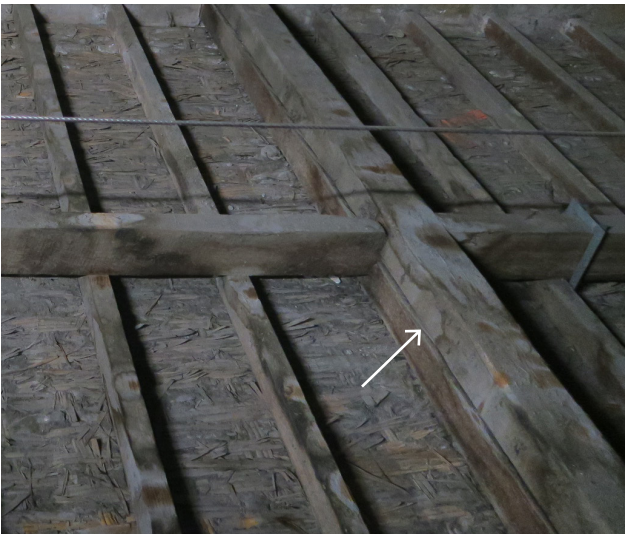
Fentes dans les poutres
