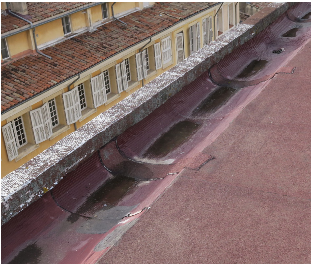
Étanchéité périphérique sur acrotère très altéré
