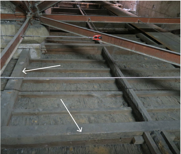
Poutres à l'angle particulièrement sollicitées
