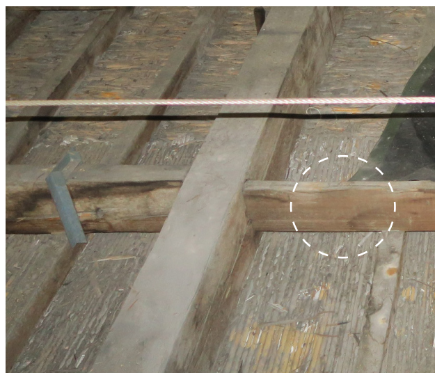
Poutres secondaires avec deux profils différents Celle de droite a été taillé en proximité de la dosse
