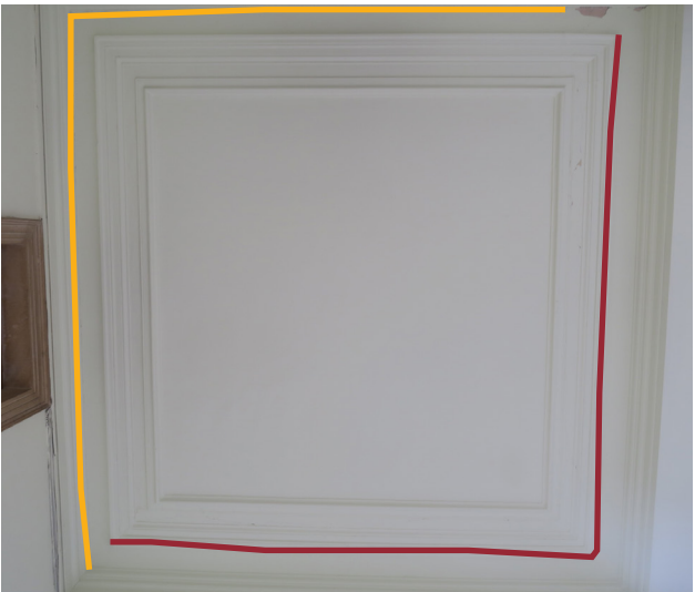
NO - Décollement et tassement du plafond plâtre
