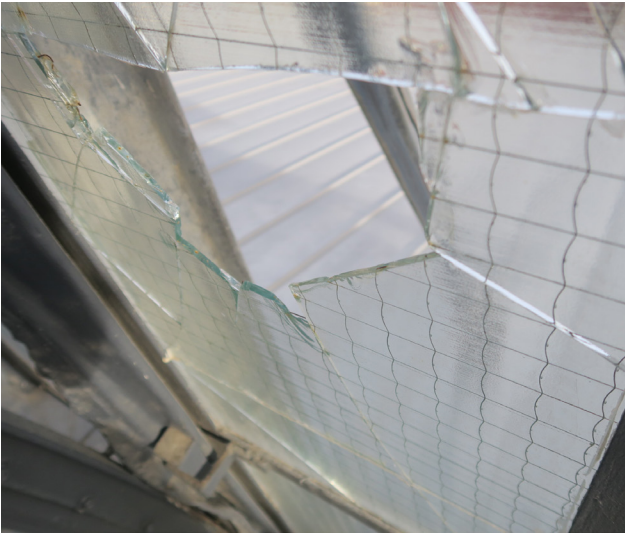
Vitré cassée, le hors d'air n'est pas assuré
