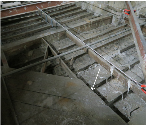
Platelage reposant sur les poutres tertiaires
