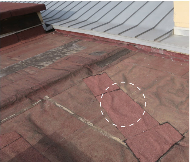
Réparations dans l'étanchéité
