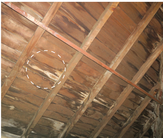
Traces d'infiltrations anciennes dans la volige
