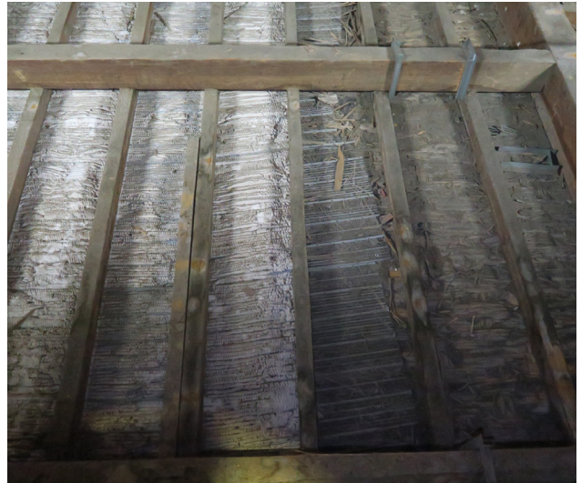
Nergalto de consolidation du canisse
