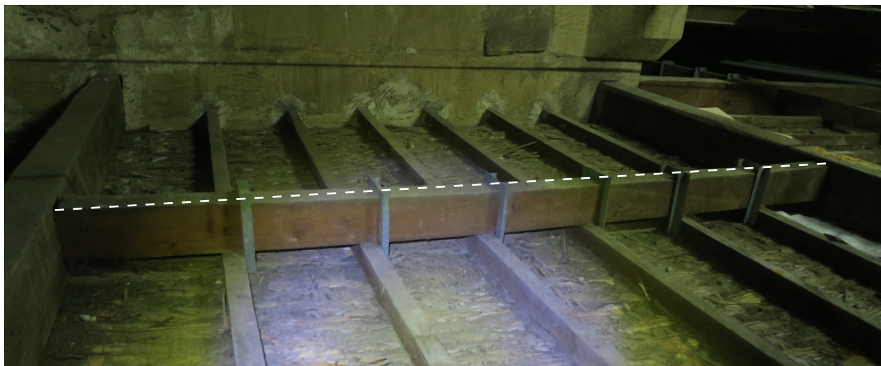
Présence d'agrafes métalliques et fléchissement de la poutre secondaire
