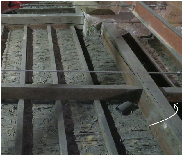
Poutre soumise à torsion
