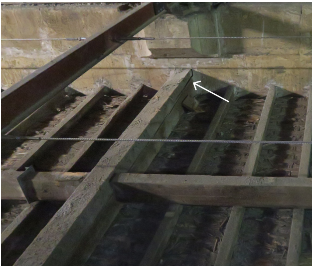
Fentes et torsion dans la poutre
