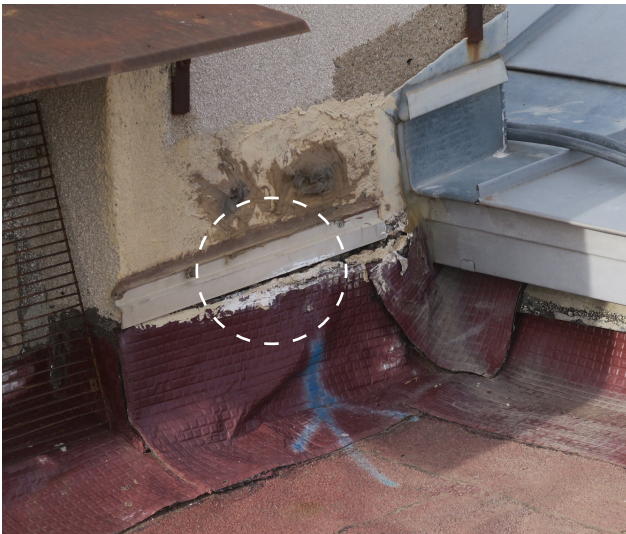
Solin détaché du relevé d'étanchéité
