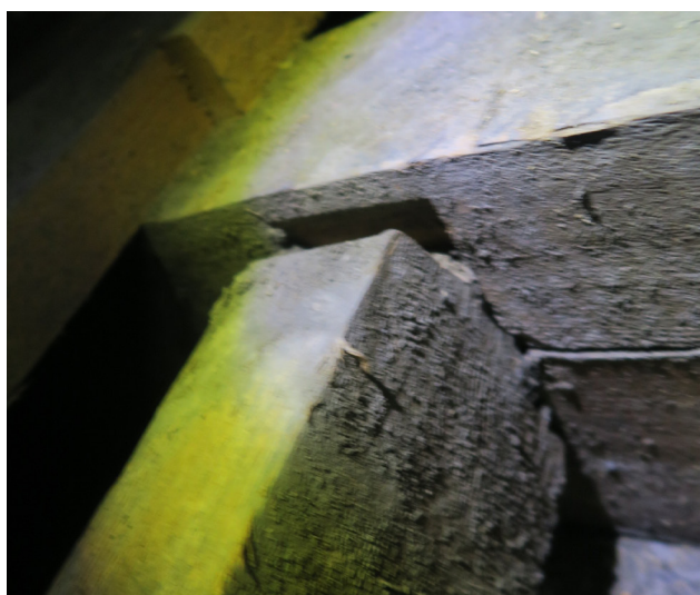
Ouverture de l'assemblage tenon-mordane
