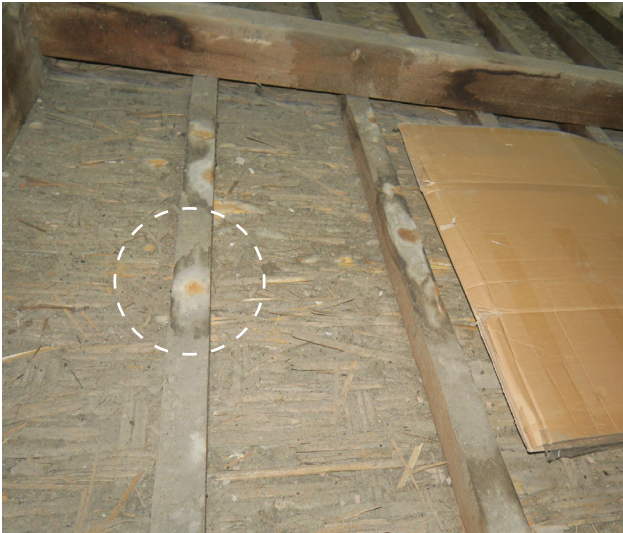
Traces d'infiltrations d'eau anciennes
