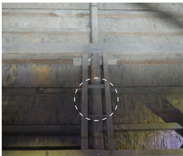
"Moise" de la poutre secondaire : les deux poutres latérales permettent la reprises des appuis des poutres tertiaires
