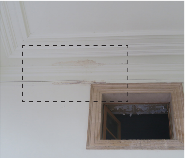
SE - Traces d'infiltrations d'eau
