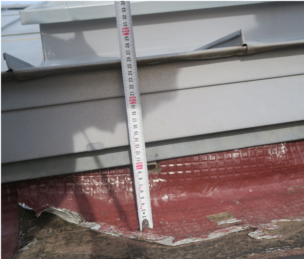
Relevé d'étanchéité insuffisant et altéré
