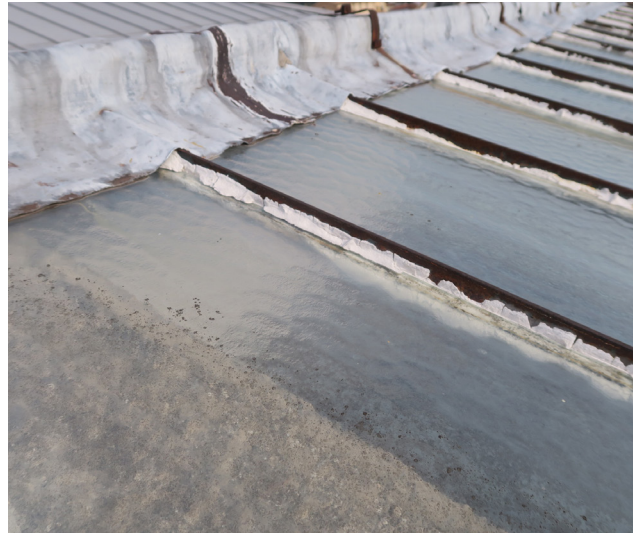
Verrière avec potentielle présence d'amiante dans le mastic
