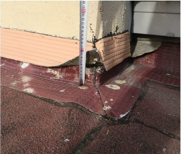
Relevé d'étanchéité insuffisant et altéré
