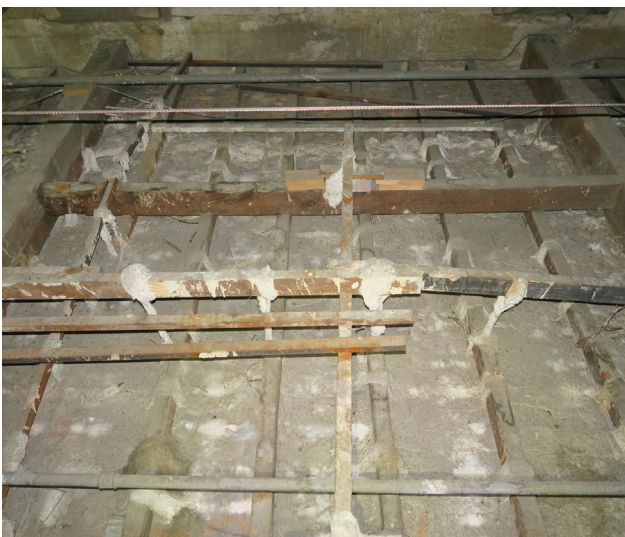
Reprises chaotiques du canisse-plâtre par polochons (liaison poutre secondaire de confort/poutres tertiaires)
