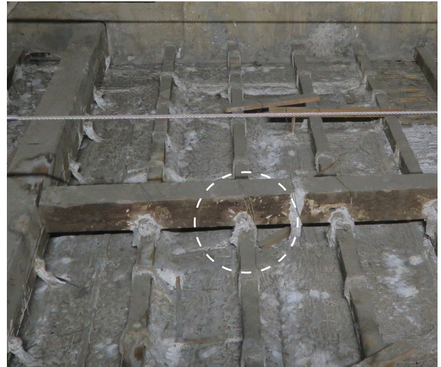
Accrochage des poutres tertiaires aux secondaires
