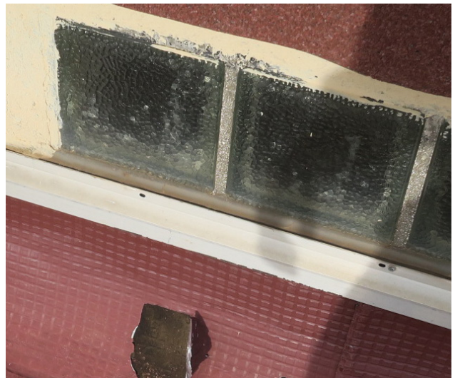
Solin avec joint en silicone fuyard
