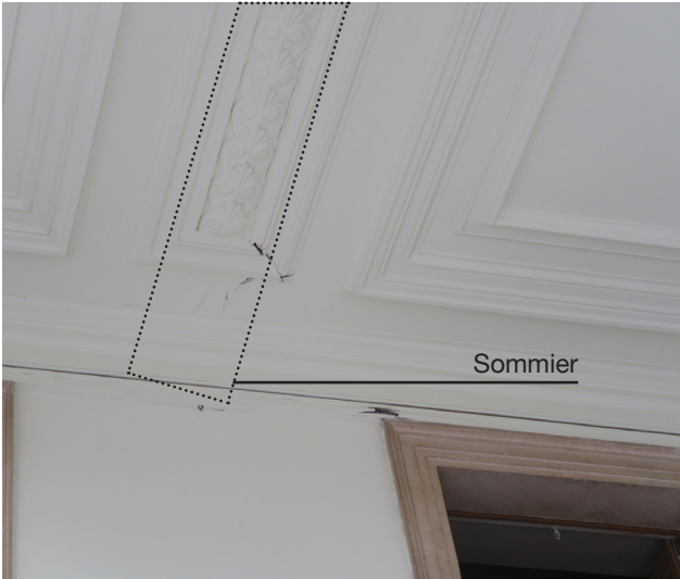
E4/E5 - Fissuration du plâtre à l'emplacement de la solive
